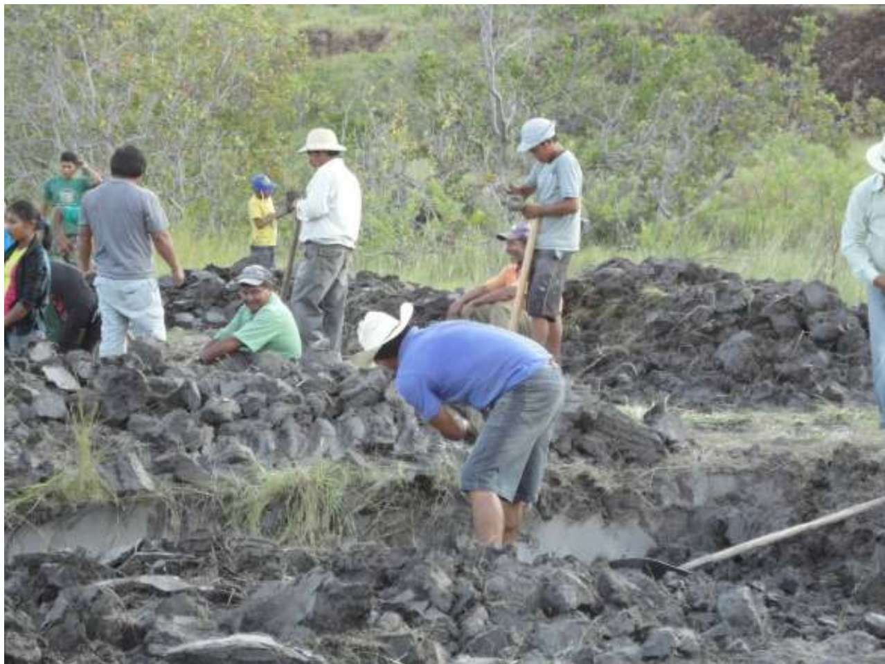
Lavori di scavo per la realizzazione dell'invaso a Maturuca
