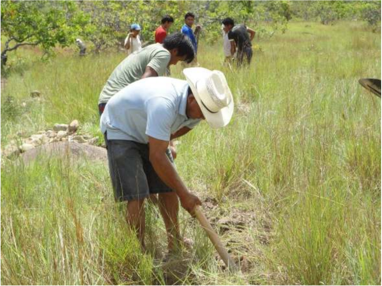
I lavori per la posa delle tubature che porteranno l'acqua all'invaso (Maturuca)
